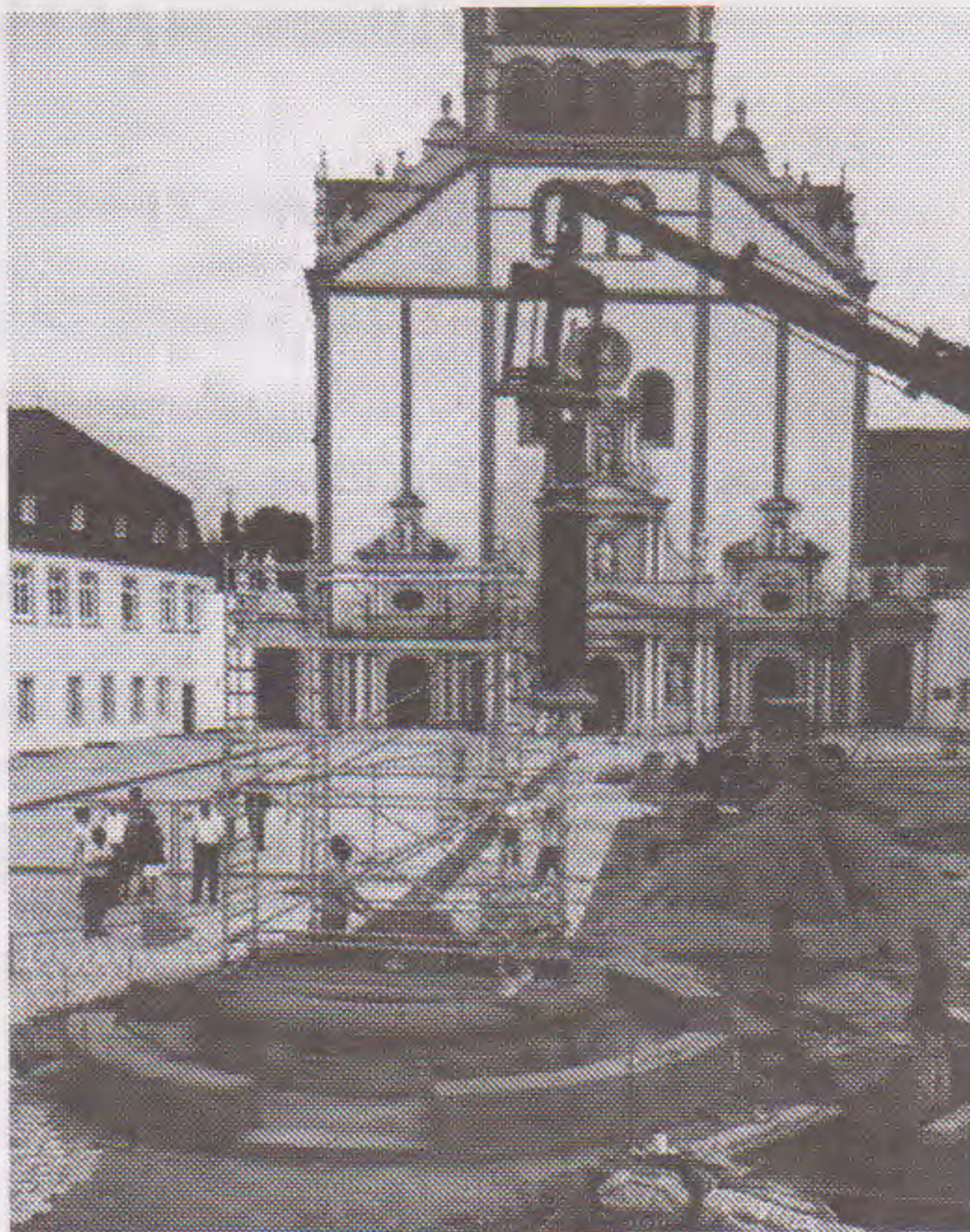
Ein Kran setzt den Schaft des Pacelli-Kreuzes auf den neuen Brunnen
